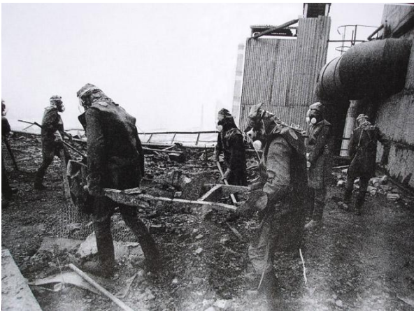
Figura 7: Vigili del fuoco al lavoro
